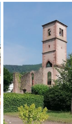
Leimbach – Les ruines de l'église Saint-Blaise.
