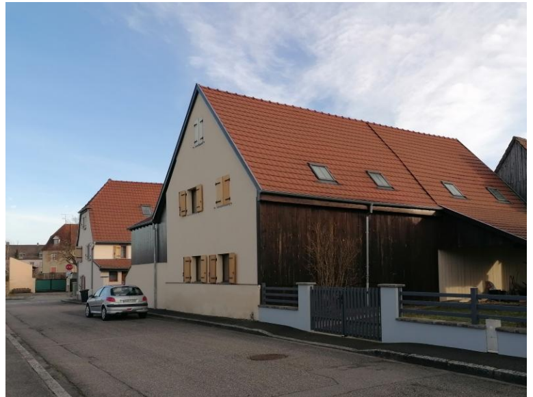
Cas d'insertion architecturale récente dans un contexte architectural patrimonial à Ottmarsheim
