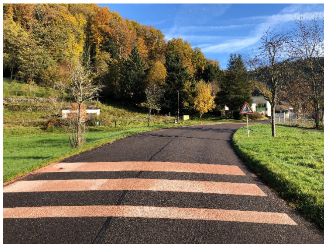
La traversée de la RD 466 à Oberbruck est un exemple de bonne pratique : Signalisation au sol, panneau d'avertissement et marquage de la traversée au sol – Photo Afut Sud-Alsace
