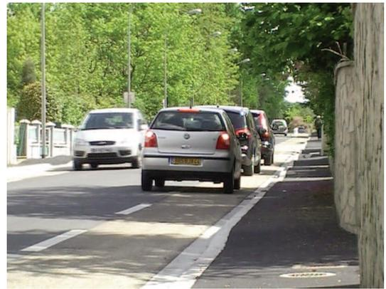
Exemple de chaussée à voie centrale banalisée en milieu urbain
