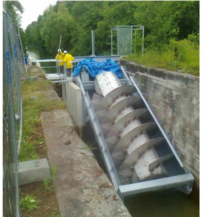
Une vis d'Archimède permet, soit de remonter de l'eau, soit de produire de l'énergie à partir d'une chute, ce qui est envisagé dans le cadre de ce projet.
