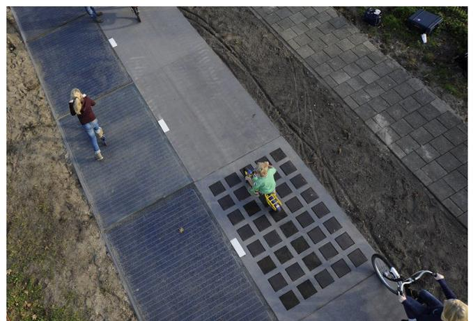
*La piste repose sur des modules de béton de 3,50 x 2,50 mètres qui intègrent des capteurs solaires. Ces derniers sont protégés par du verre trempé d'un centimètre d'épaisseur, antidérapant, afin d'éviter les glissades.*
