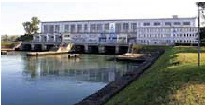
La centrale hydraulique d'Ottmarsheim utilise le débit du cours d'eau, sans capacité significative de modulation du stockage. L'aménagement du Rhin pour utiliser sa force motrice a permis cette installation.
